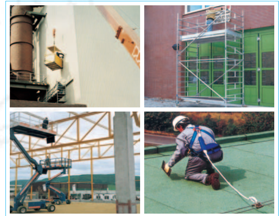
Bild 1-3: Maßnahmen gegen Absturz auf hoch gelegenen Arbeitsplätzen
