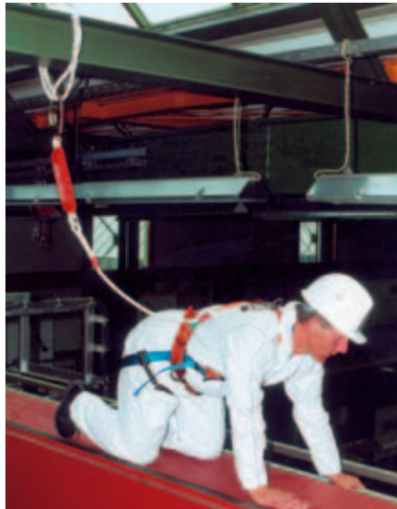
Bild 2-12: Verbindungsmittel mit Bandfalldämpfer
