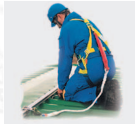
Bild 2-18: Anschlagvorrichtung als horizontale Führung
