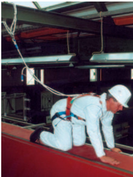
Bild 2-11: Verbindungsmittel mit Reibungsfalldämpfer
