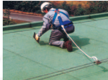
Bild 2-18: Anschlagvorrichtung als horizontale Führung
